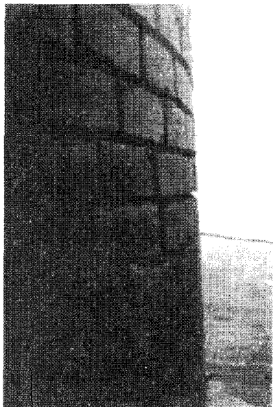
Рис. 137. Разрушения в швах кладки ствола трубы
